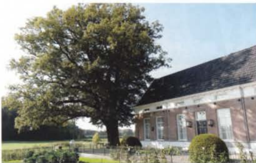
Het langgerekte boavneand van de Wigger aan de Losserssestraat na restauratie (2014)
