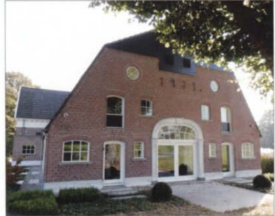
Het nieneand van de Wigger na de restauratie (2014). De bouwstijl vind je ook in het westen van Münsterland.
